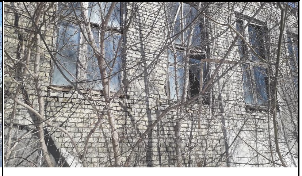
Фото №6 Фасад здания
