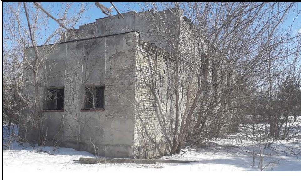
Фото №5 Фасад здания
