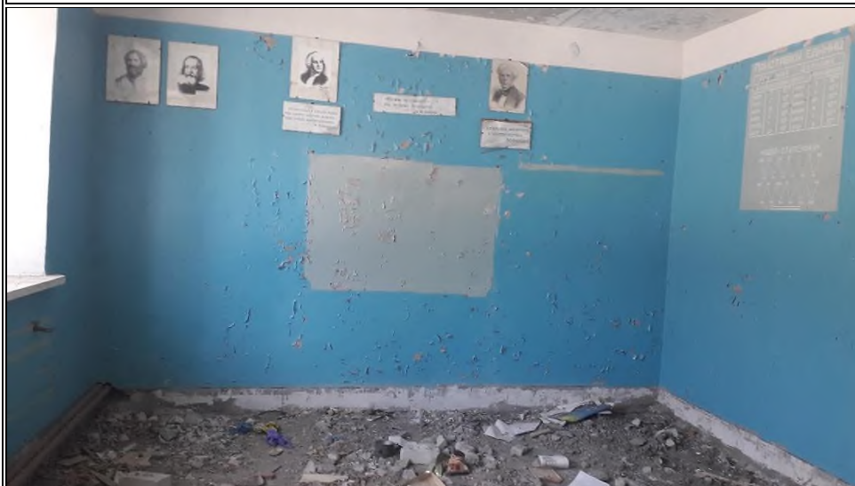
Фото №27 Нежилое здание
