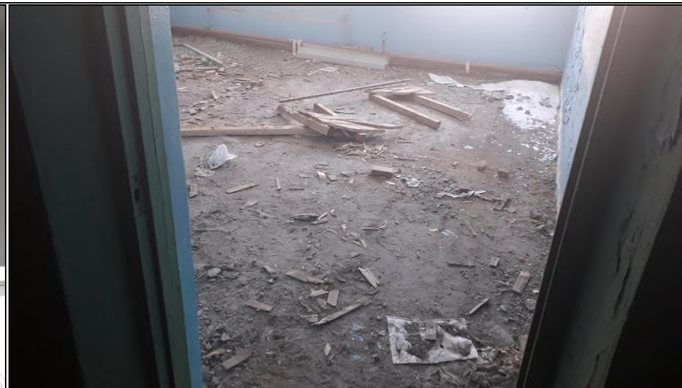
Фото №26 Нежилое здание
