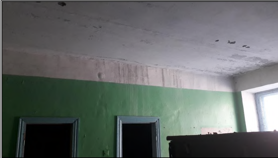
Фото №13 Нежилое здание
