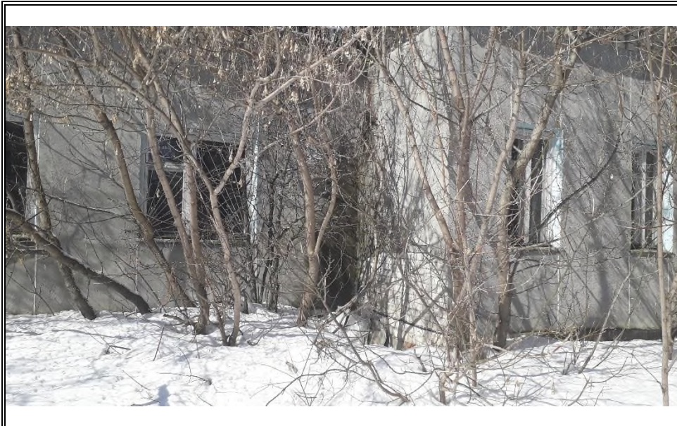
Фото №1 Фасад здания
