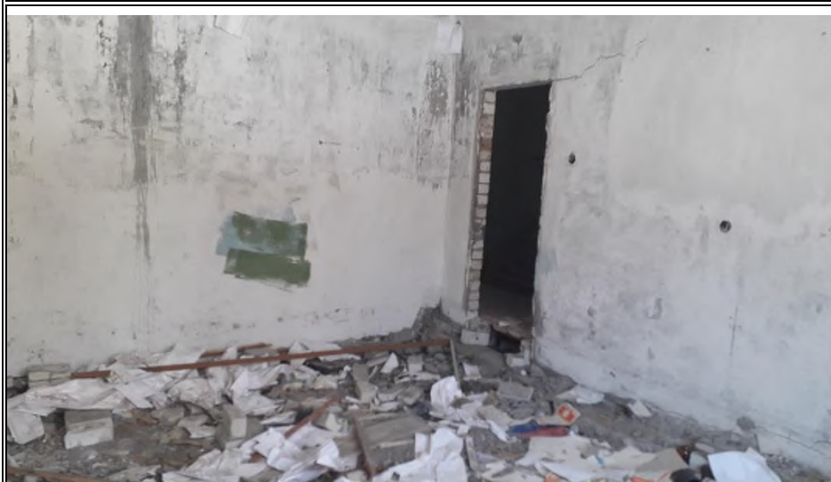
Фото №31 Нежилое здание
