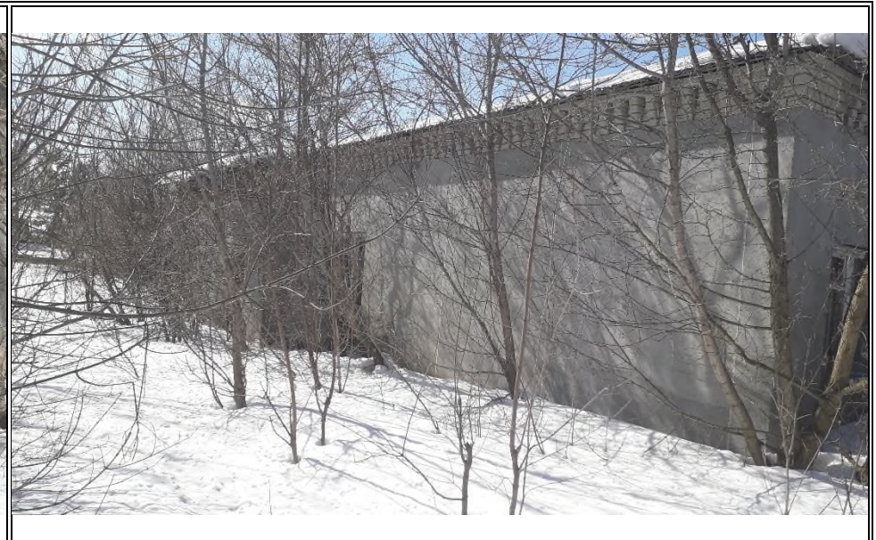
Фото №2 Фасад здания
