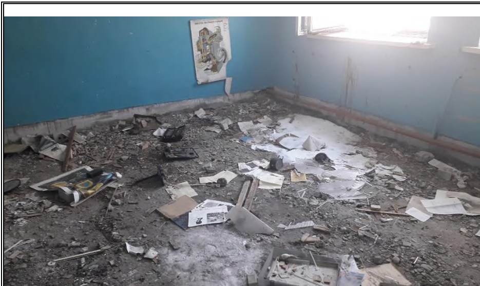
Фото №29 Нежилое здание
