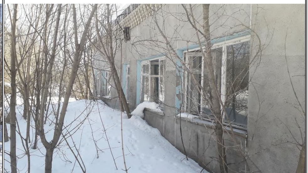
Фото №4 Фасад здания
