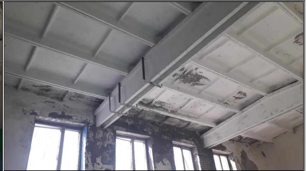
Фото №18 Нежилое здание
