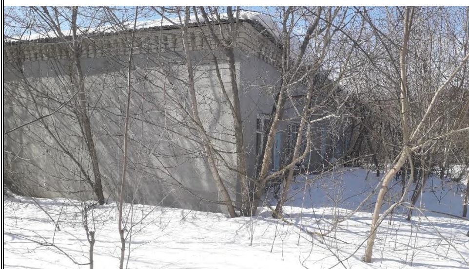
Фото №3 Фасад здания
